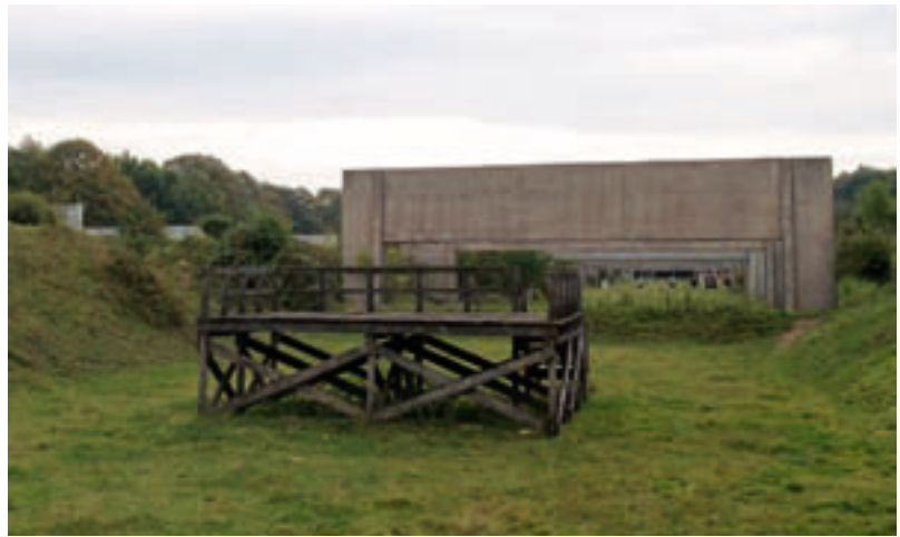
4 Schießbahn mit auf der Rückseite unverkleideten Betonblenden, vom Kugelfang aus gesehen.
